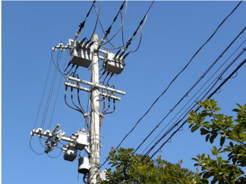
Las compañías eléctricas suelen transportar la electricidad usando tensiones muy altas porque así es más económico. Luego usan transformadores para distribuirlas a las casas en forma de tensiones más bajas.
